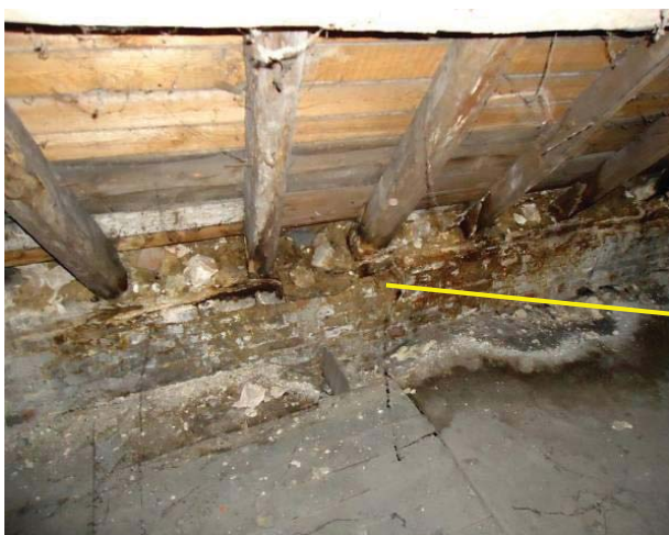
Dakvlak 14, detail rotte muurplaten en nat staand metselwerk
